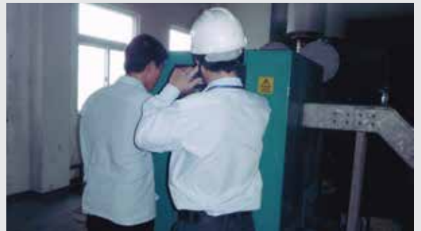
故障排除，發電機供電
