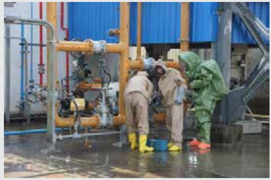
維修組人員進行搶修
