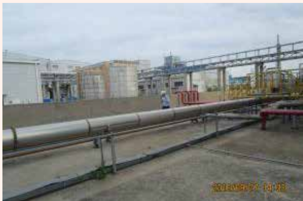
儲罐氣體報警器報警、人員到場查看。
