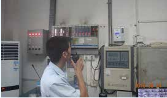
氣體洩漏報警器動作
