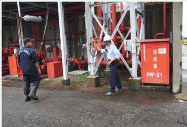
確認火災後，按壓現場火警發信機通報全廠，並向119通報。
