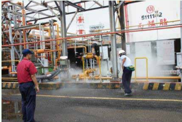
現場發現火災時，進行初期滅火。
