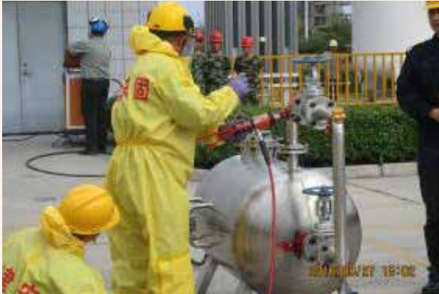
壓力管道中法蘭、與罐體連接處、管線本體發生洩漏的帶壓堵漏操作。
