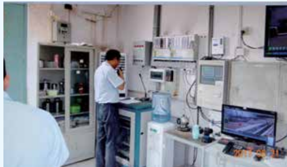
通知消防隊趕往現場
