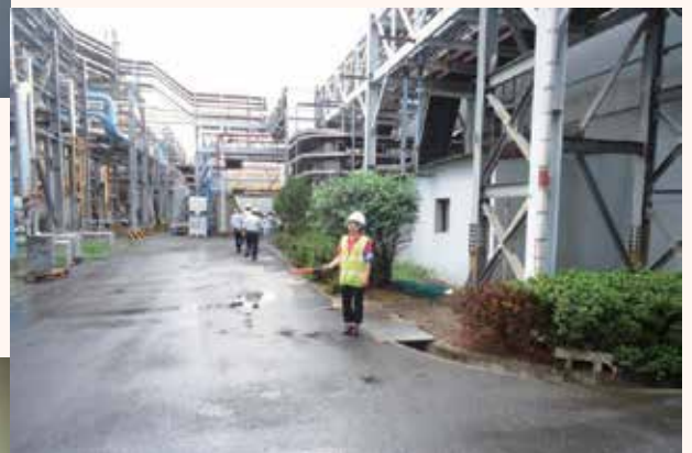
現場人員避難逃生情形。
