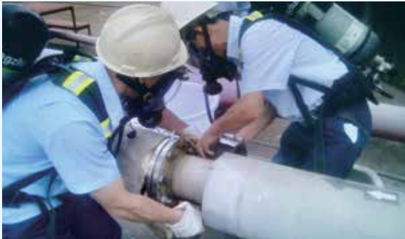
搶修小組進行管道封堵
