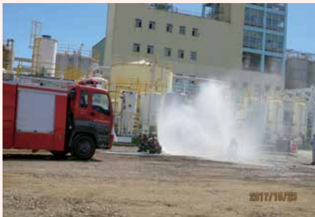
消防水帶出水。
