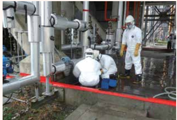
維修組人員進行洩漏管線維修。
