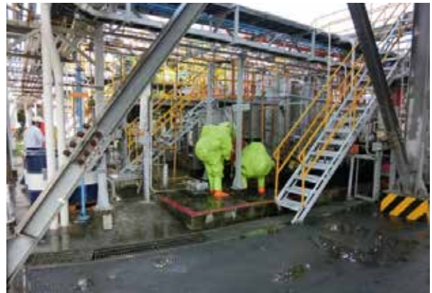
操作員穿著A級防護衣，到洩漏處進行洩漏隔離止漏。
