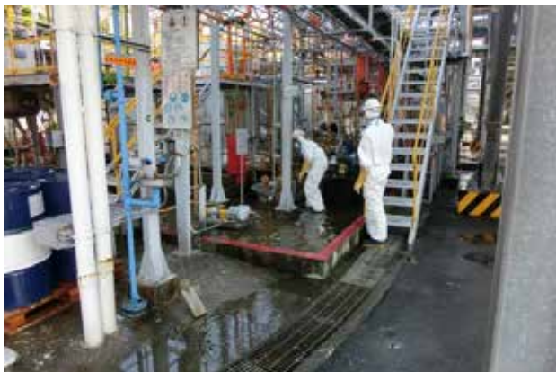
維修人員穿著防護衣進行受損管線維修。
